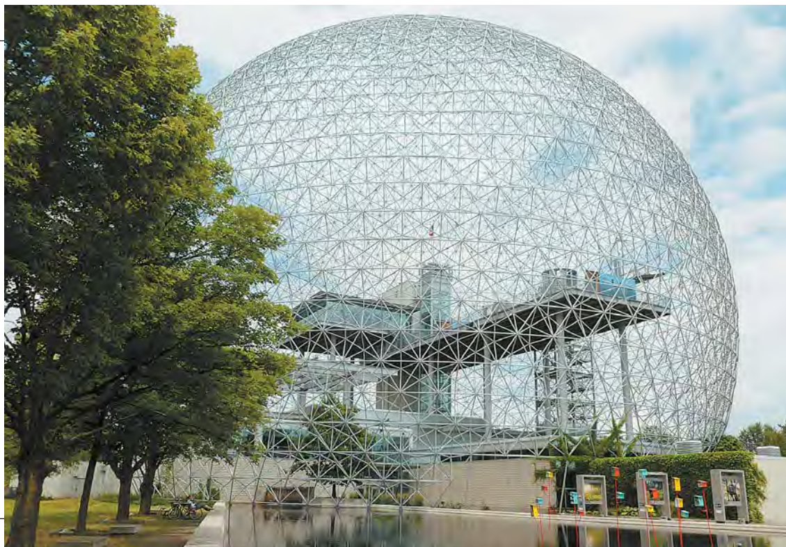
Один из так называемых геодезических куполов, созданных Фуллером, состоит из правильных геометрических фигур.
