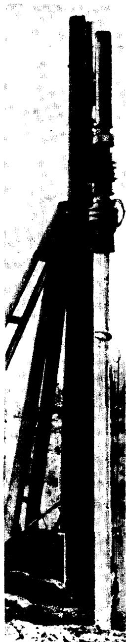
Рис. 174. Копер для забивания свай
